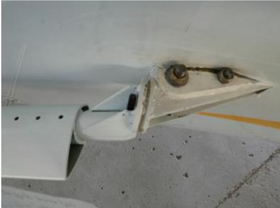
Foto 4: punto di attacco superiore dell'asta di controventatura al ventre alare (semiala destra).
