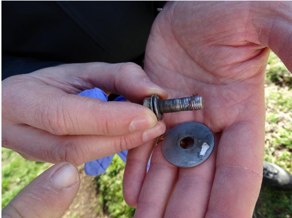
Foto 21: dettaglio della vite di fissaggio dell'asta di controventatura all'intradosso della semiala destra.
