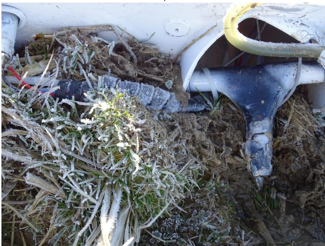
Foto 20: dettaglio del sistema di vincolo della semiala destra (" T " shape connection).
