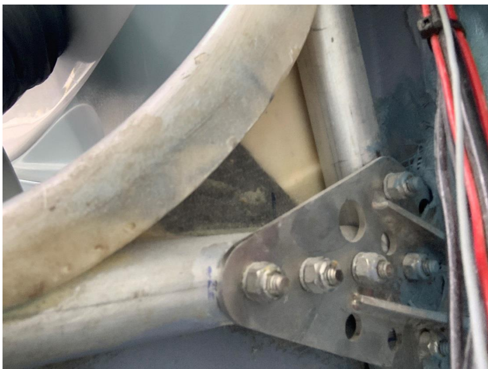
Foto 7: vista da dietro della piastra metallica di vincolo dell'asta di controventatura e dei tubolari di alluminio della struttura (attacco asta di controventatura semiala destra). Fotografia effettuata durante il sopralluogo ANSV su un apparecchio analogo presente sull'aviosuperficie "Leonardo da Vinci" di Vigevano.
