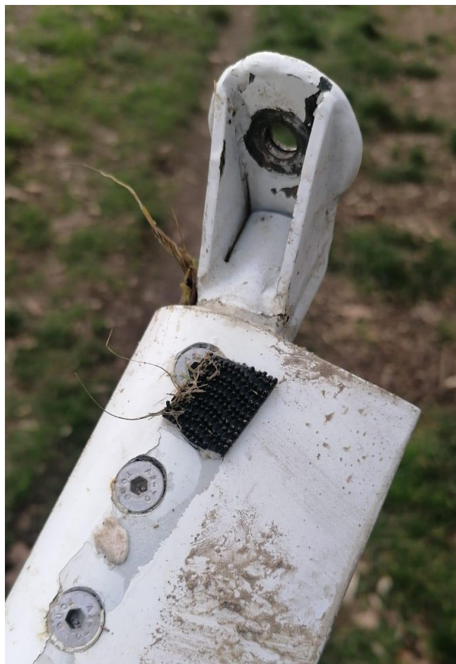
Foto 25: particolare dell'asta di controventatura della semiala destra: punto di attacco superiore separatosi dall'intradosso della semiala.
