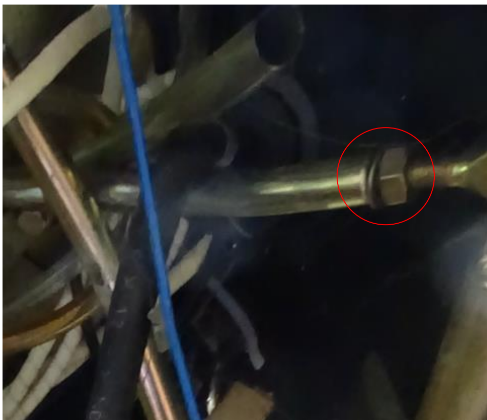
Foto 9: terminale dell'asta di un comando di volo con dado di bloccaggio allentato.
