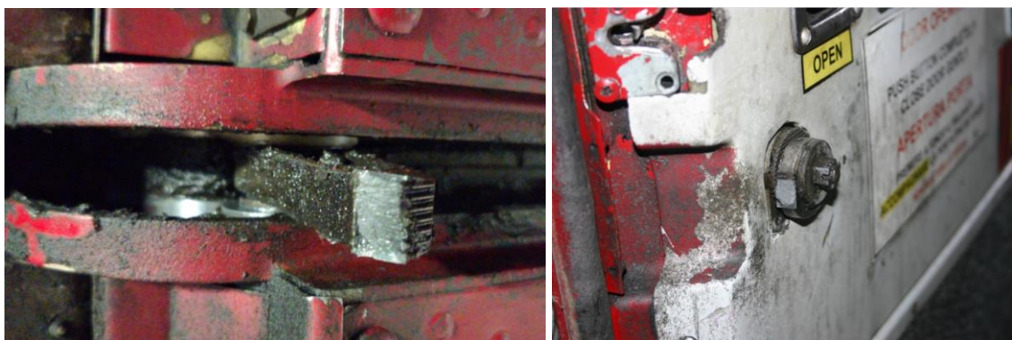
Foto 10 e 11: a sinistra, dettaglio del sistema di scorrimento nella guida centrale, fratturato; a destra, porzione complementare del vincolo del portellone al sistema di scorrimento nella guida centrale, fratturato.
