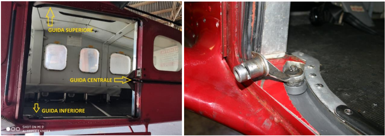
Foto 7 e 8: a sinistra, punti di scorrimento del portellone; a destra, dettaglio del sistema di scorrimento del portellone nella guida inferiore con il cilindro di sblocco in emergenza.
