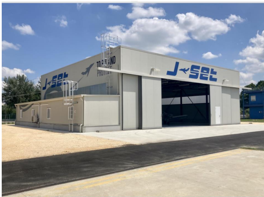
Figura 13: Realizzazione nuovo hangar
