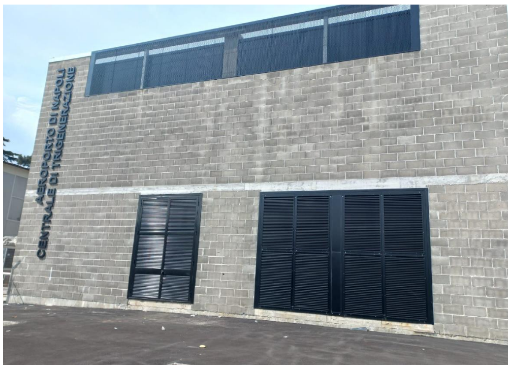
Figura 20 Centrale di tri-generazione
