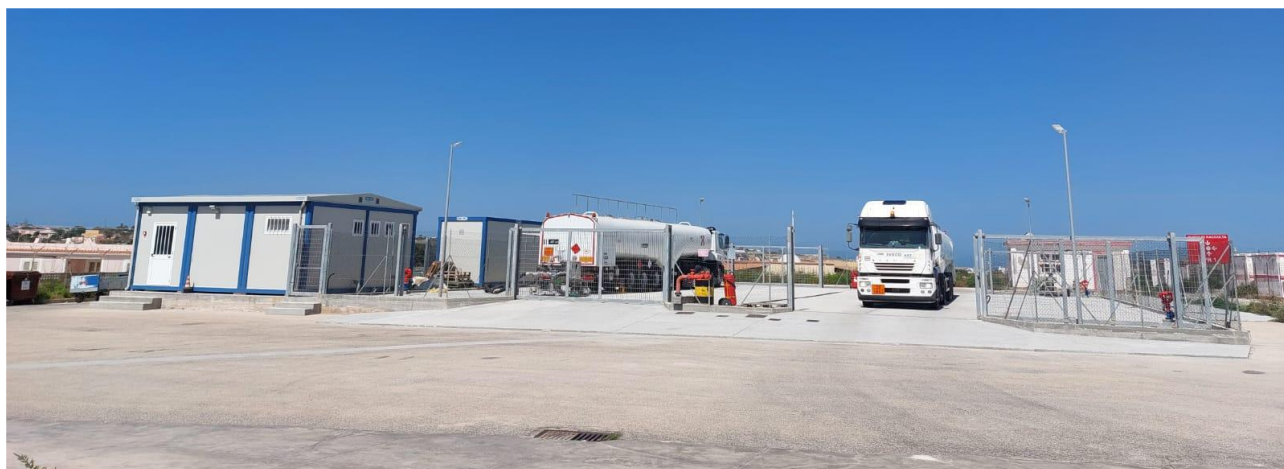
Figura 16 Nuova stazione carburanti
