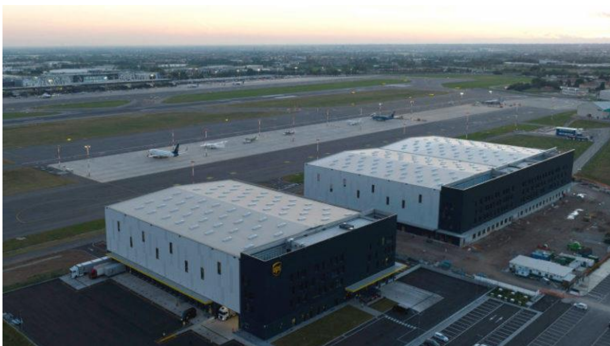
Figura 4 Capannoni nuova area cargo
