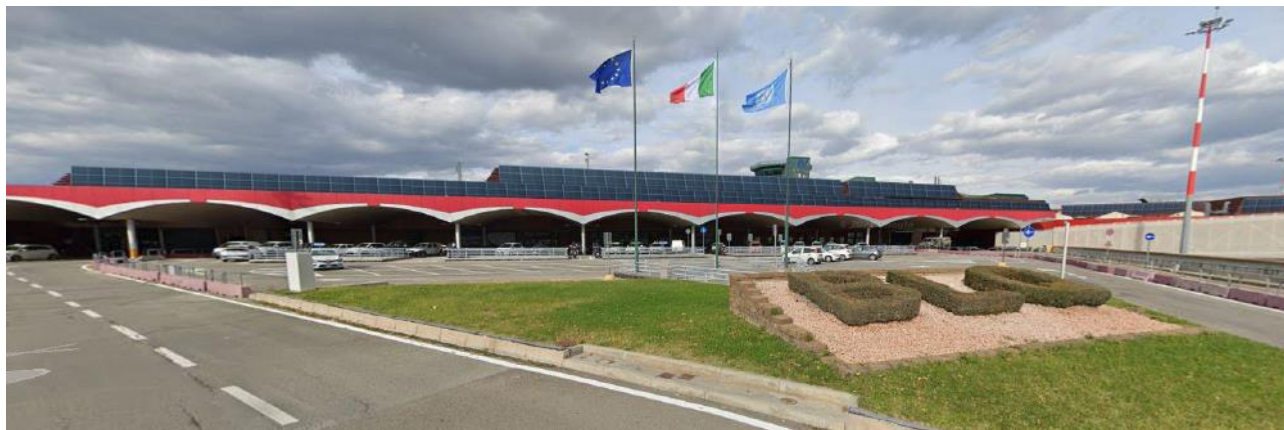
Figura 7 Impianto fotovoltaico Terminal
