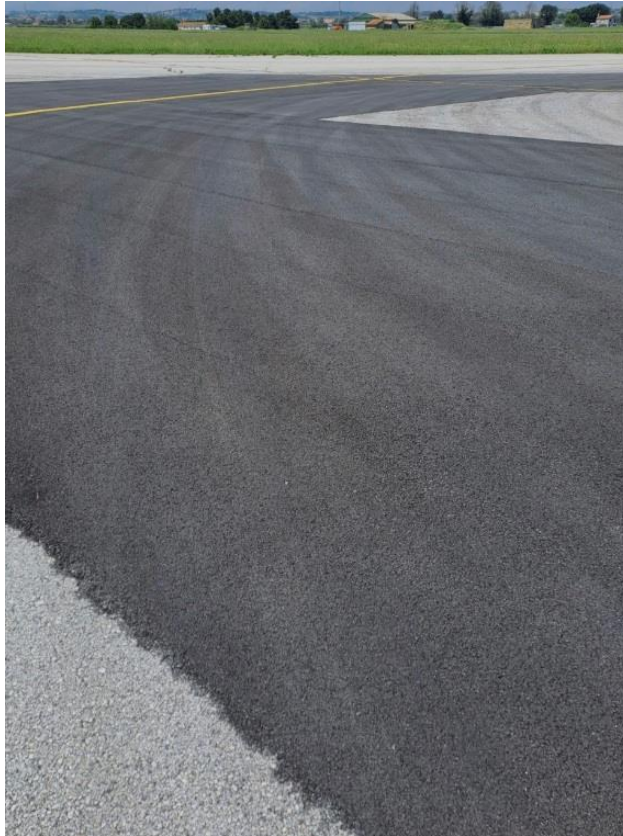
Figura 2: riqualifica localizzata pavimentazione TWY T
