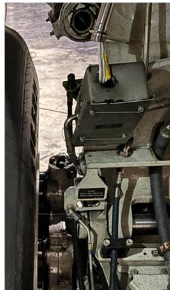
Foto 18: sensore air-ground del carrello principale di destra.
