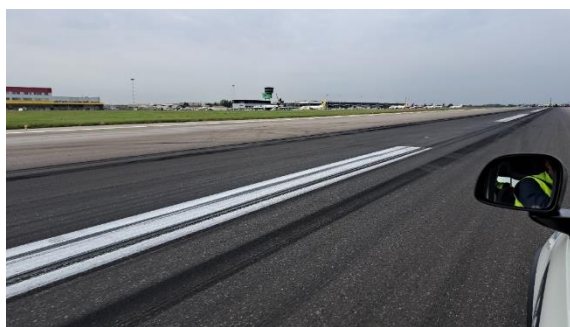
Foto 4: tracce bloccaggio pneumatici sulla pista (Fonte SACBO).
