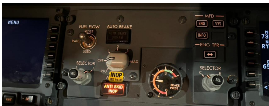
Foto 23: spia antiskid INOP ed evidenza dell'etichetta gialla di avviso di sistema inoperativo.
