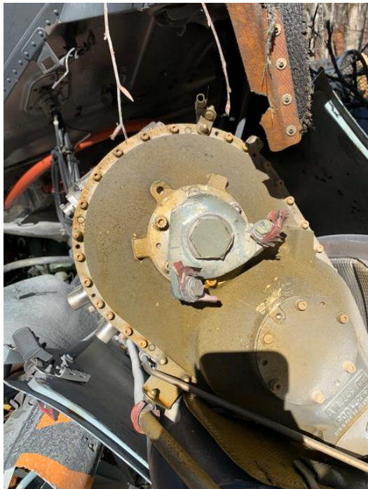
Foto 24: rottura delle flange dell'albero di trasmissione del moto al rotore di coda.
