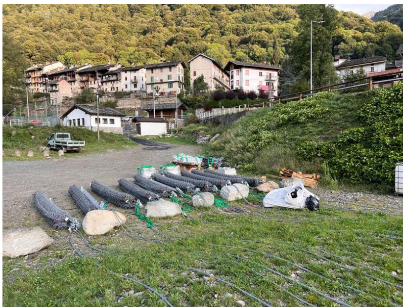
Foto 7: piazzola di carico e scarico merci.
