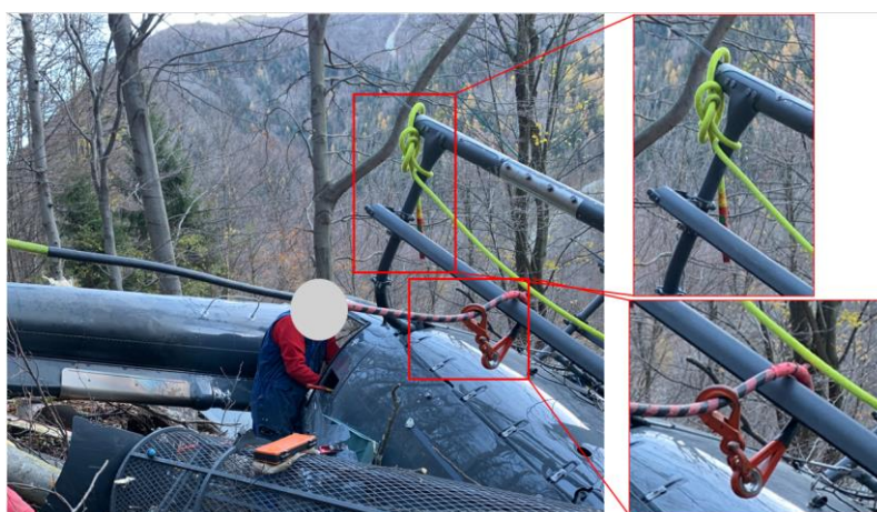
Foto 15: particolare delle estremità della fune di carico.
