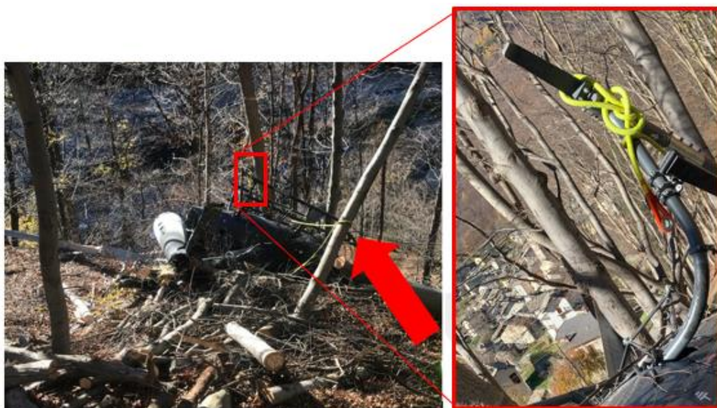
Foto 14: fune di carico legata al tronco di un albero.
