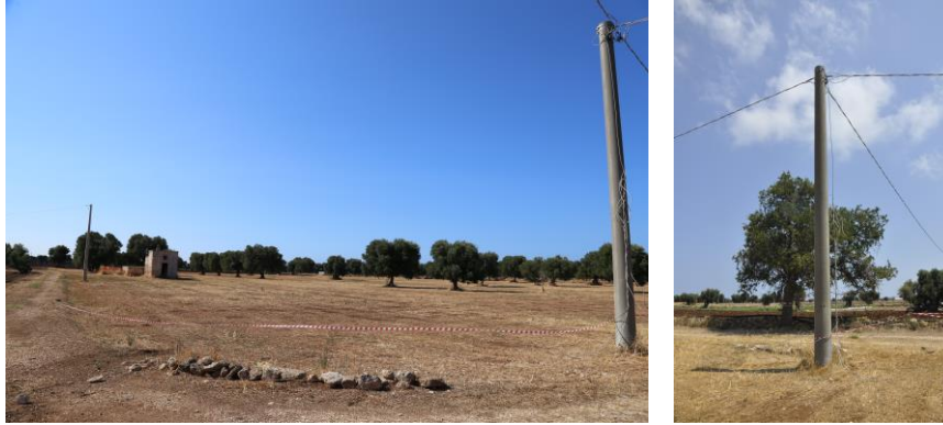
Foto 7 e 8: a sinistra, linea elettrica tranciata; a destra, cavo elettrico tranciato.
