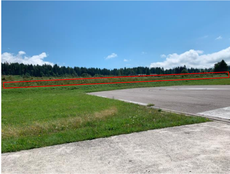
Foto 2: terrapieno al di sotto della recinzione.
